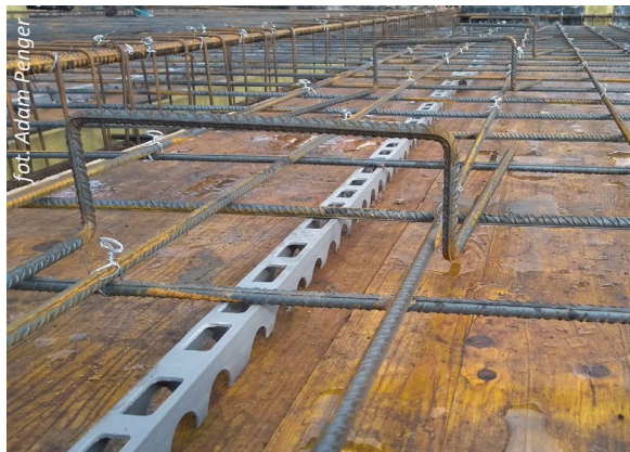
Dolne zbrojenie płyty stropu leży na listwie dystansowej, pod górne przygotowano „kobyłki”.
