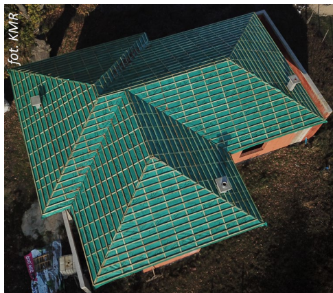
Membranę dachową układa się na krokwiach lub deskowaniu, pod rusztem z łąt i kontrłąt.
