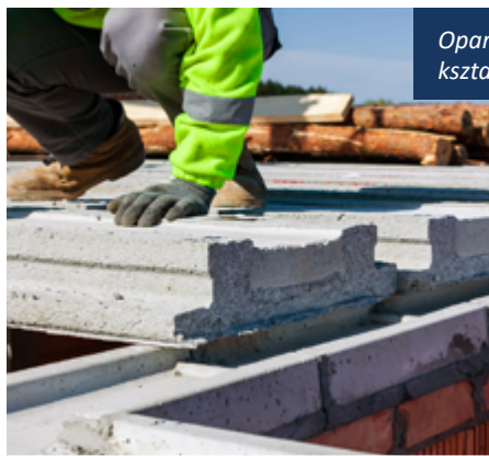
Montaż lekkiego stropu panelowego SMART na ścianach, na kształtkach wieńcowych.
