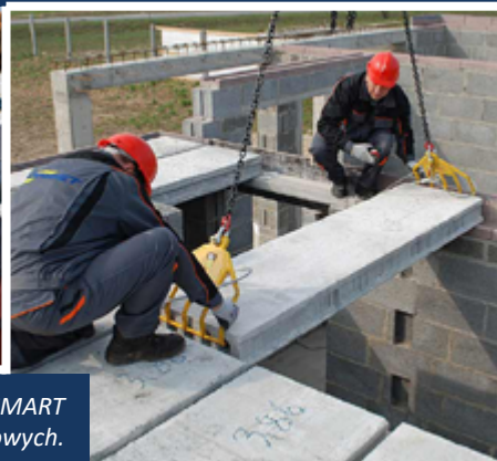
Oparcie płyt stropu TERIVA PANEL na pośrednich kształtkach wieńcowych typu "C".
